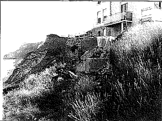
Fig 19 Wimereux Nord : désordres sur habitation
